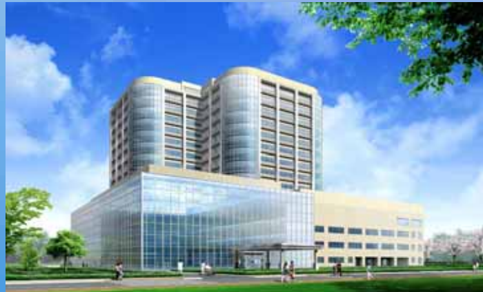
新湘南鎌倉総合病院(平成22年9月完成予定)
